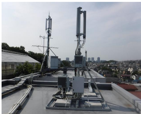
アンテナ工事施工例
